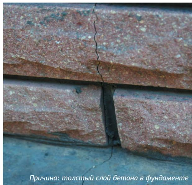
Причина: толстый слой бетона в фундаменте
