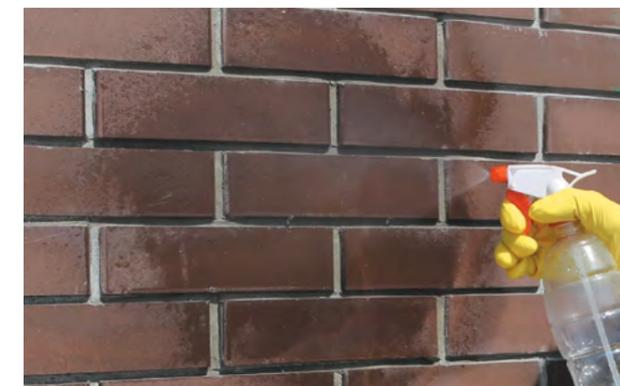
Нанесения гидрофобизатора распылителем
