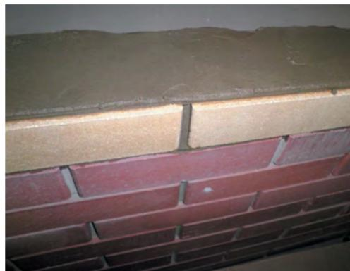
Аналогичным образом укладывается раствор на тычковую и боковую сторону кирпича (при кладке тычкового ряда). Несколько кирпичей ставятся вертикально на ровной поверхности. На них при помощи этого же шаблона укладывается раствор.
