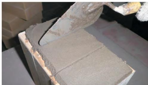
Этот раствор прорезается кельмой между отдельными кирпичами, и затем кирпич с нанесённым на него раствором укладывается на постель.
