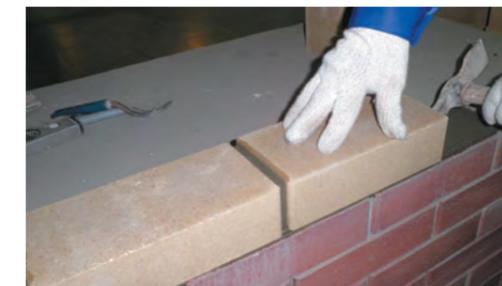
При кладке нашего кирпича не нужно насыпать раствор на кладку лопатой, подрезать раствор кельмой и подбирать с земли упавший раствор. Расход раствора при такой кладке в несколько раз ниже, чем при обычной. И главное - лицевая поверхность кирпича не пачкается раствором.
