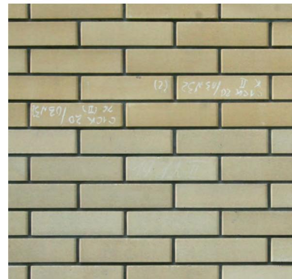
Вести кладку под специальный шаблон, для того чтобы было полное заполнение швов раствором, а также для предотвращения попадания кладочного раствора на лицевую поверхность кирпича. Нельзя вымазывать лицо кирпича, так как при оттирании и отмачивании его сильными кислотами может теряться цвет и происходить химическая реакция с известняком-ракушечником.
